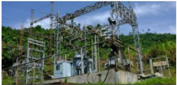
APEX -Fam shaft (1052 KVAR, 4.16KV) Lamsan, Inc.
